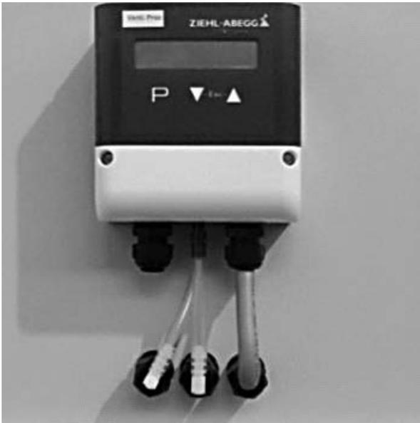
Die Regelung der Regenerationsluft ist werkseitig konfiguriert und bedarf keiner weiteren Einstellung.
