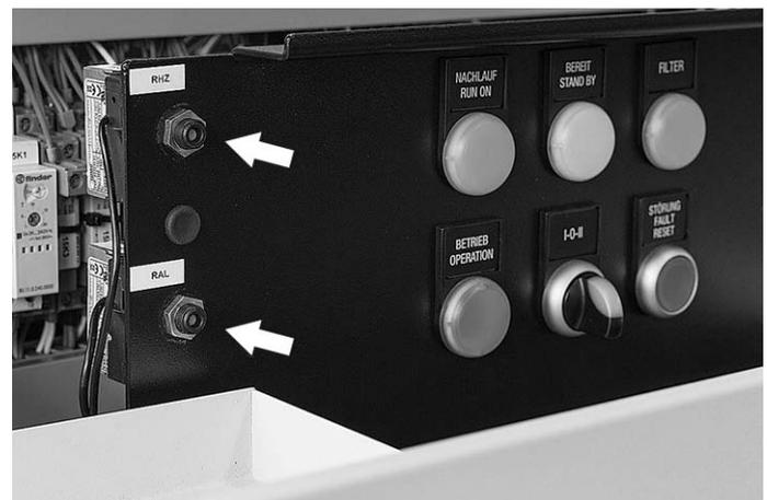
3. Drücken Sie danach zum Quittieren der STB-Störungen oder der  $\Delta p$ -Störungsmeldung den Taster STÖRUNG / FAULT – RESET (38).
