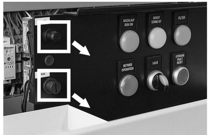
2. Drücken Sie den entsprechenden Reset-Taster und setzen Sie die Abdeckung wieder auf.
