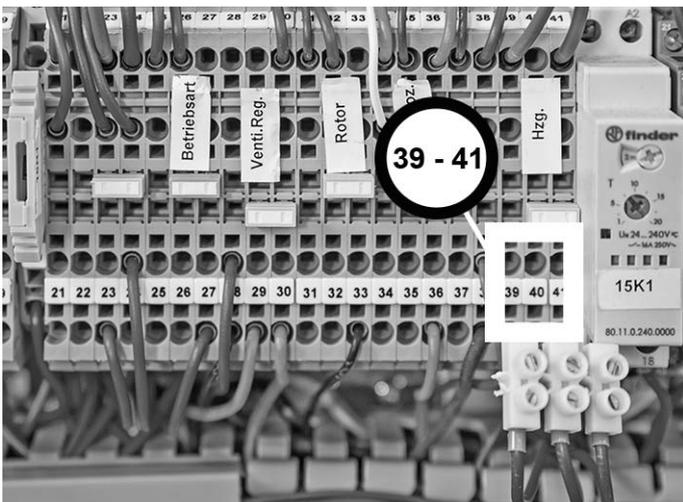
6. Stecken Sie eine Steckbrücke von X6.40 nach X6.41. Damit sind die Änderungsarbeiten abgeschlossen.
